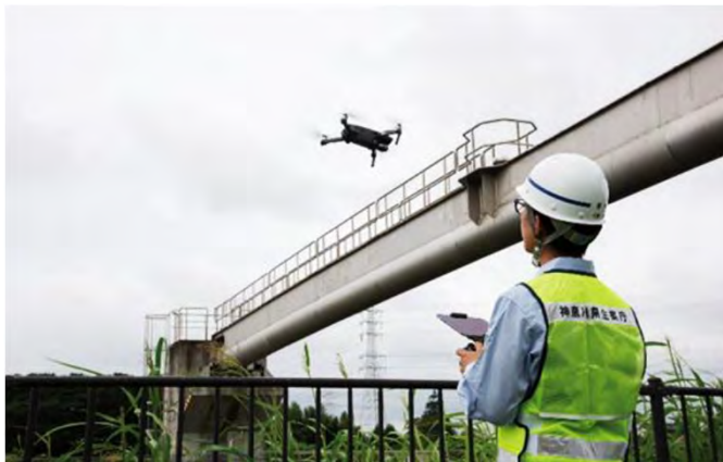
ドローンによる水管橋の点検
