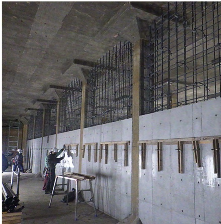
片瀬配水池(藤沢市)内部に新たに耐震性の高い壁を施工している様子
