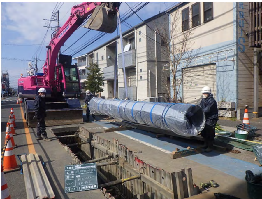
茅ヶ崎市赤羽根～東海岸基幹管路更新工事 耐震継手管据付工の様子
