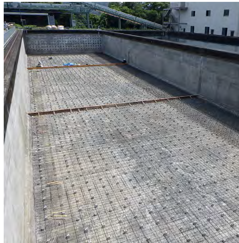
谷ヶ原浄水場横流沈澱池(底面)のコンクリートを厚くしている様子
