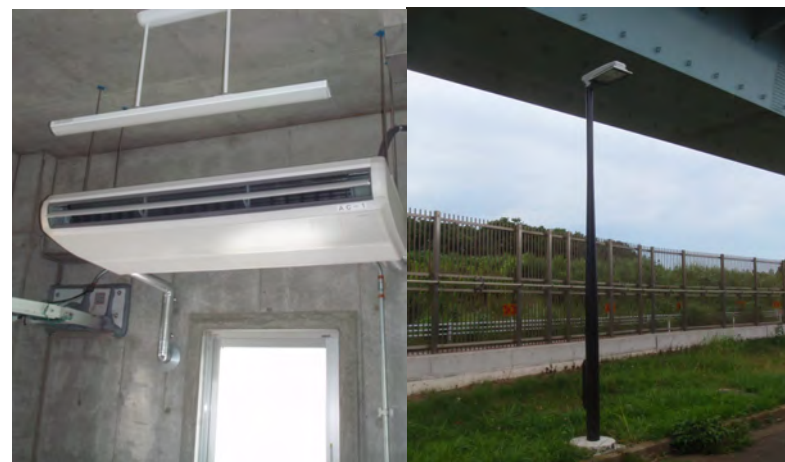
更新した空調設備や照明器具
