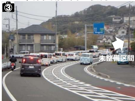
・ 2車線供用区間の状況
