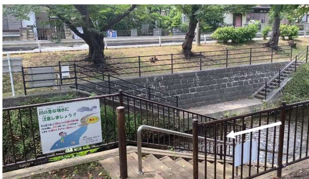
福田15号橋上流（整備予定箇所）
