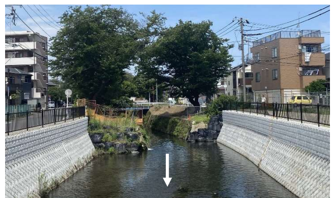
福田14号橋下流（整備済・予定箇所）
