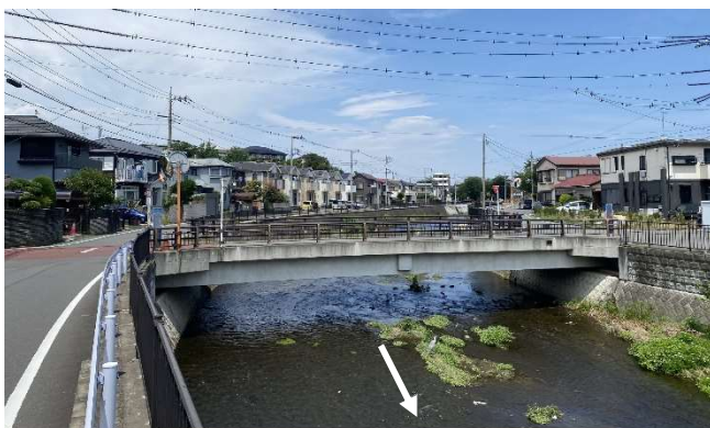
福田8号橋付近（整備済箇所）
