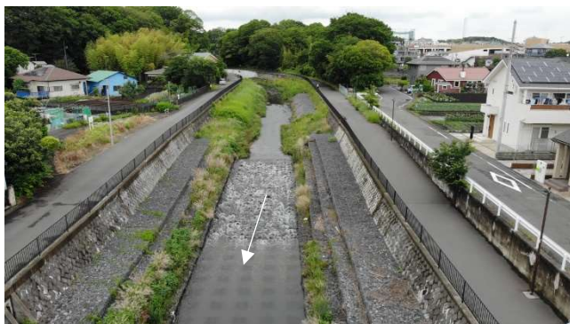
根岸橋上流（整備済箇所）
