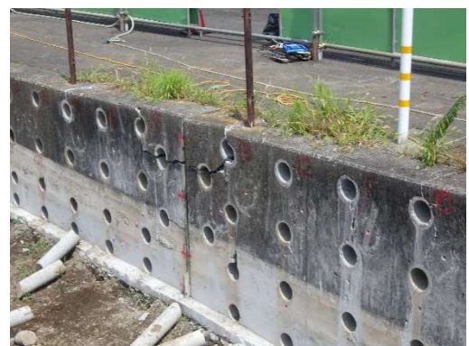
静的破碎工 (山根橋上流既設擁壁)
