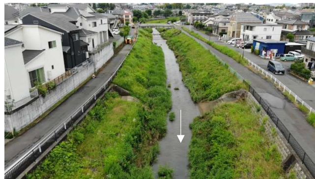
共和橋上流（未整備箇所）
