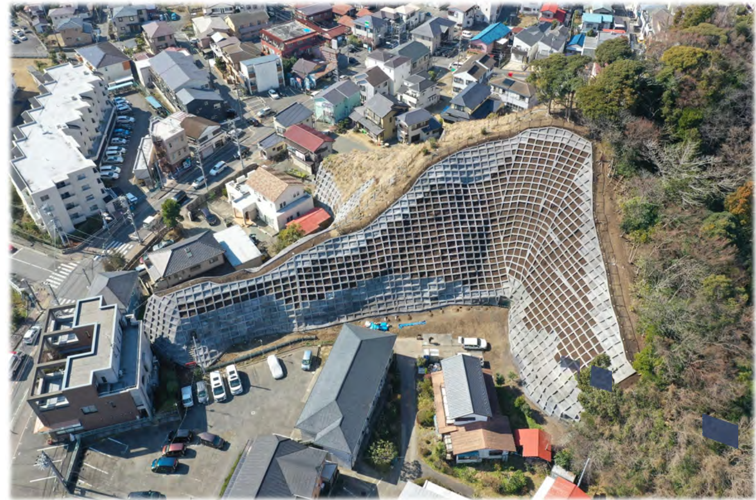
急傾斜地崩壊対策工事の状況（急傾斜地崩壊危険区域 植木D地区）
