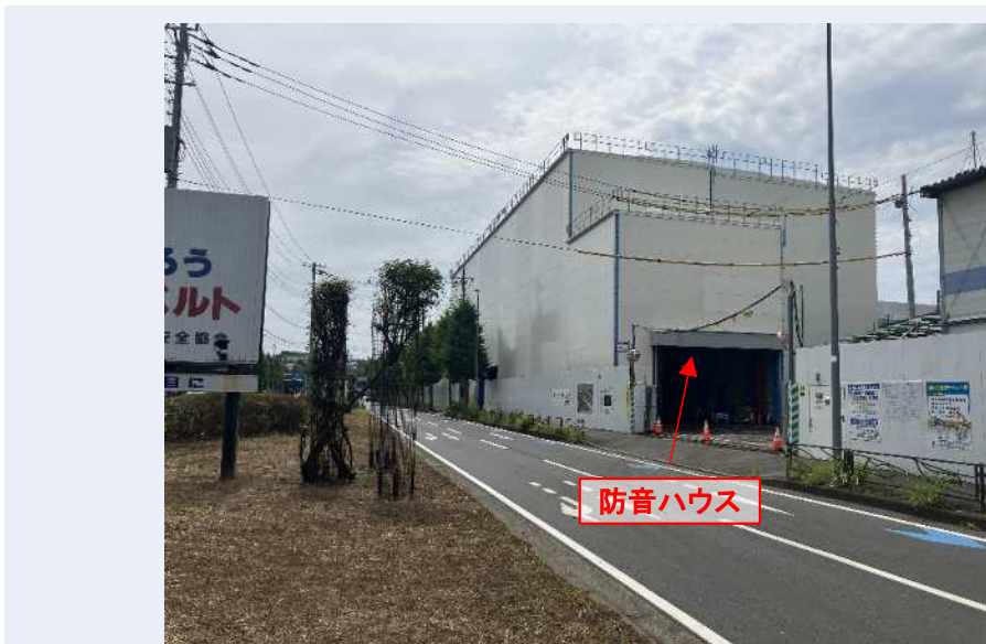
工事ヤード(防音ハウス)全景
