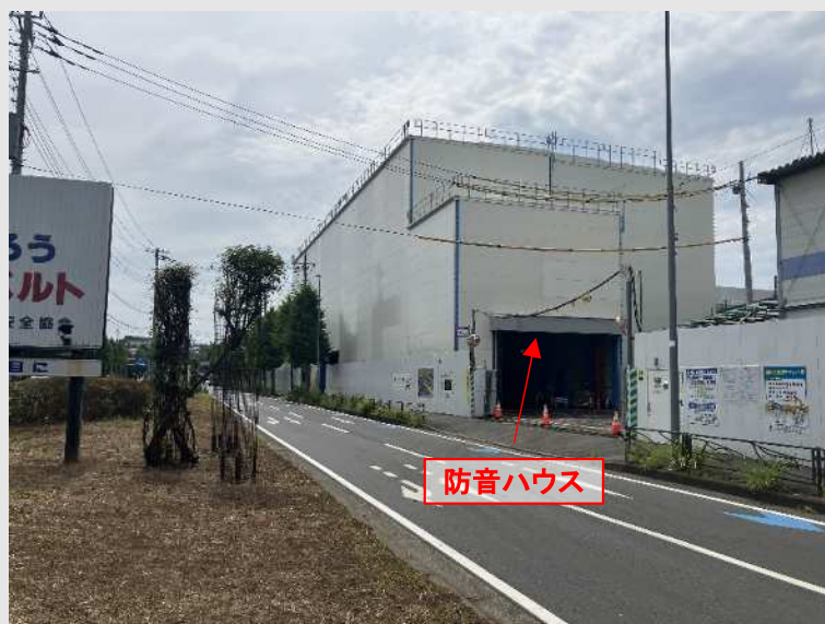
工事ヤード(防音ハウス)全景
