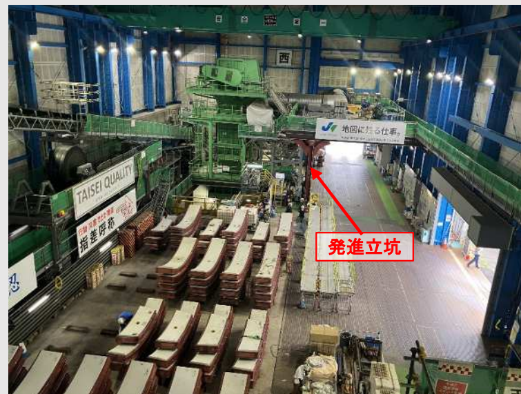
防音ハウス内部(発進立坑)
