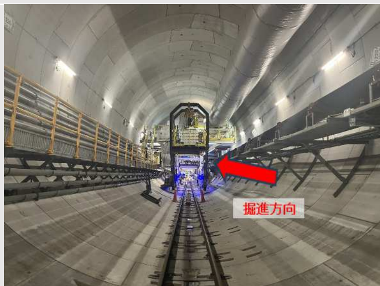
トンネル坑内(発進立坑から1,497m地点)
