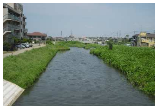
整備に合わせて土で護岸を覆い、植生を施した小出川の多自然川づくり (寒川町大曲 鷹匠橋上流)
