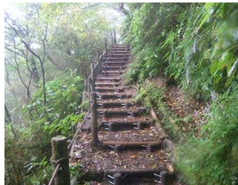
補修を行った箱根外輪山周廻歩道
