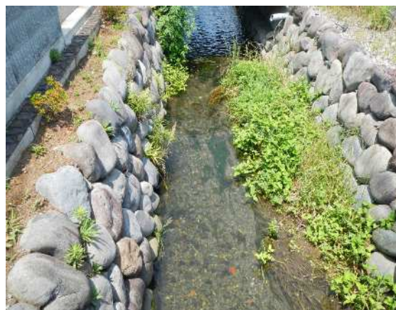
伏流水や湧水を遮断しない護岸整備により 生きものに配慮した川づくり （小田原市堀之内）
