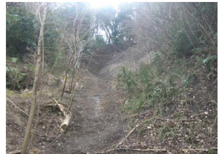
景観等に配慮した防災工事の実施 (鎌倉市大町)
