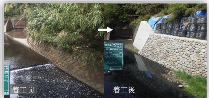
玉石を用い、多孔質な護岸に整備し、生物の生息に適した構造としました。
