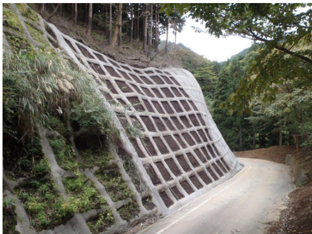
写真2-7 林道改良工事実施状況 [唐沢林道]
