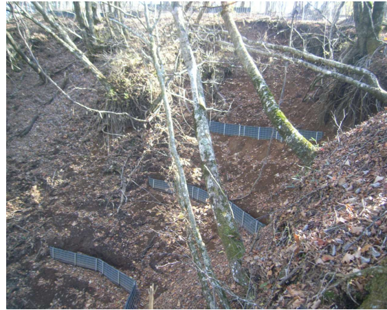
写真1-8 金網筋工設置状況(平成25年度設置) [相模原市緑区鳥屋地内]
