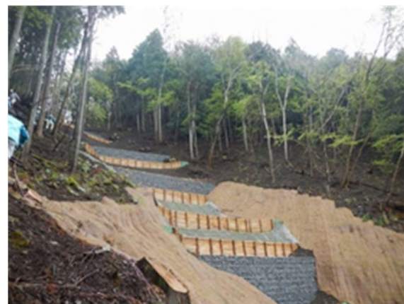
写真7-8 各種緑化手法を施工した治山工事箇所 [山北町山市場地内]
