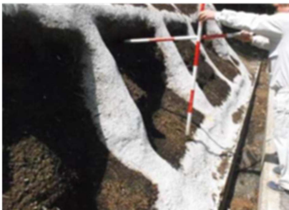
写真7-7 緑化試験施工箇所のモニタリング状況 [伊勢原市日向地内日向林道]
