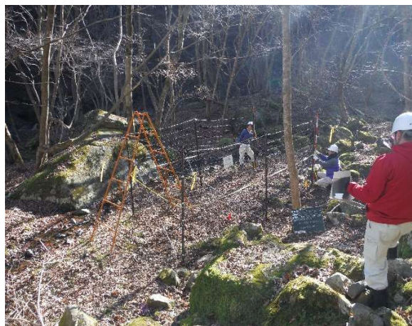
写真9-2 植生保護柵補修を行った箇所 [清川村煤ヶ谷地内]
