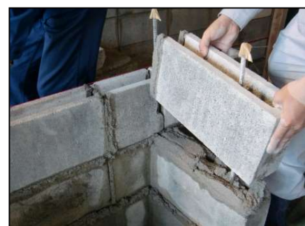
ブロック施工実習
