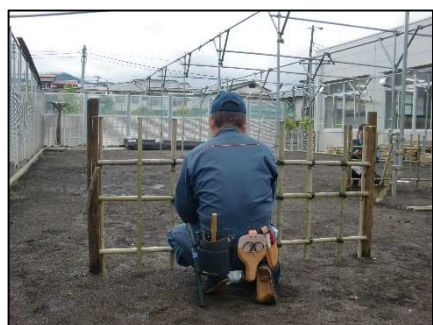
垣根施工実習（四ツ目垣）
