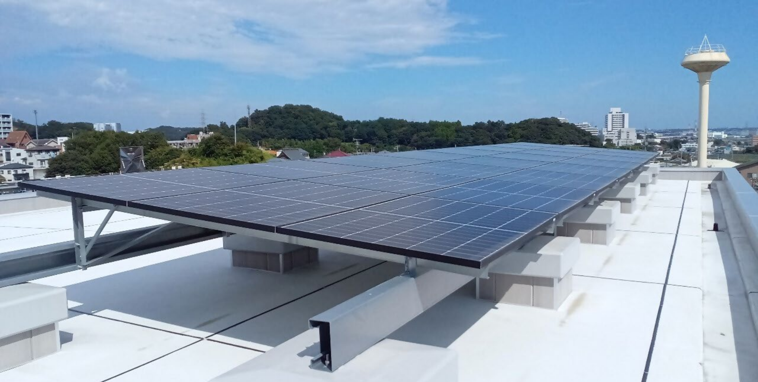
県営伊勢原峰岸団地公営住宅電気設備工事（1期）
