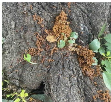
図3 株元に堆積したフラス
