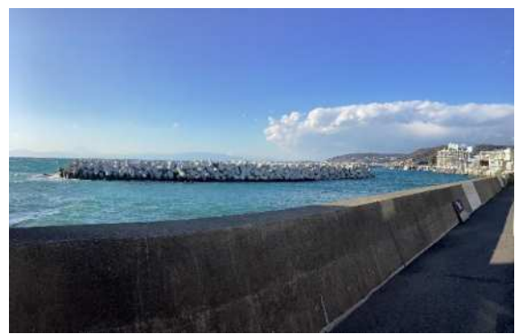
離岸堤（横須賀市営佐島漁港）
