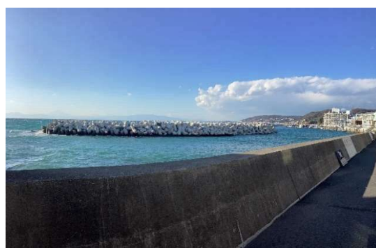
離岸堤（横須賀市営佐島漁港）
