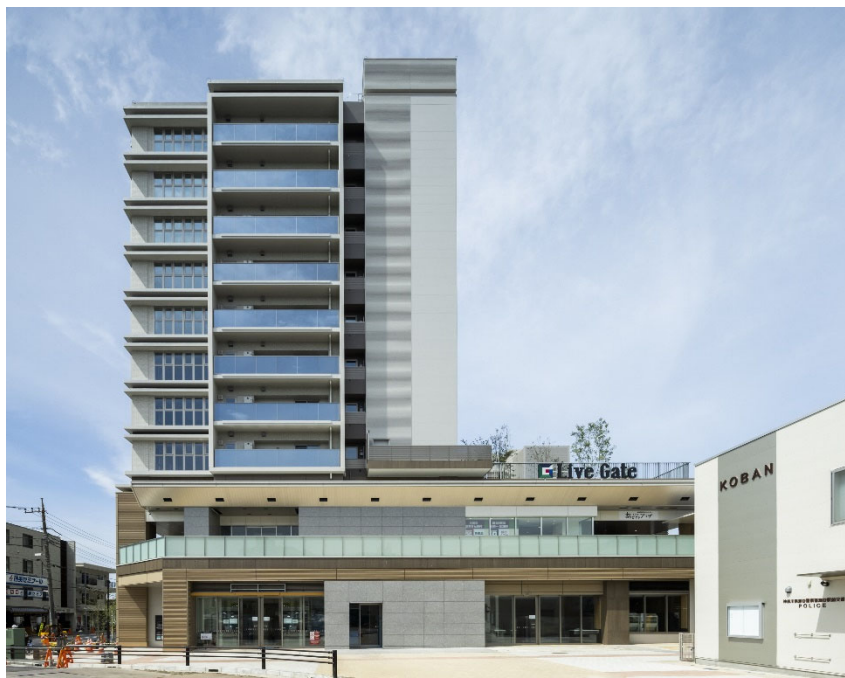
〈瀬谷駅南口第一地区(市街地再開発事業)(横浜市)〉
