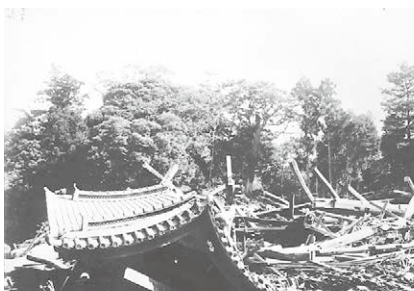
倒壊した遊行寺 (藤沢市)
