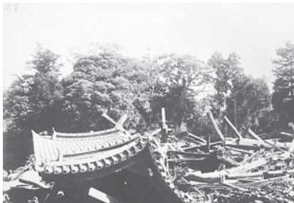
倒壊した遊行寺(藤沢市)
