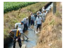
水路の泥上げ
