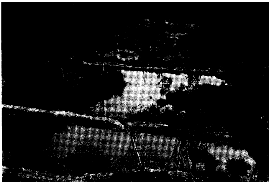
写真9 湿地に造った素掘りの池（1983年） 水もれか所は鋼板や木板等で補強した
