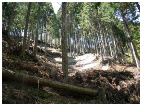
写真13：丸太筋工設置箇所（大滝沢）
