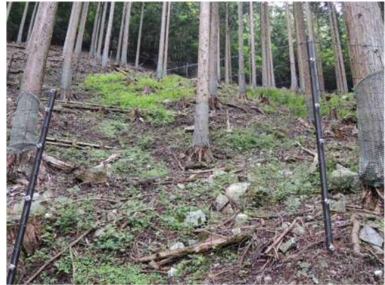
【施工後】（平成 27 年 6 月撮影）
