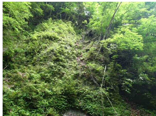
崩壊地で現在も不安定な箇所の例
