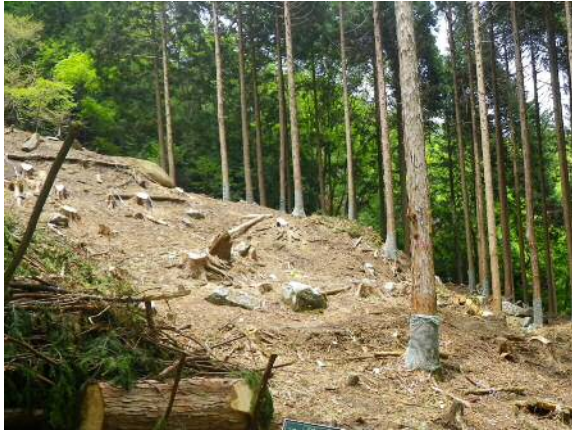
【施工直後】（平成 25 年 4 月撮影）
