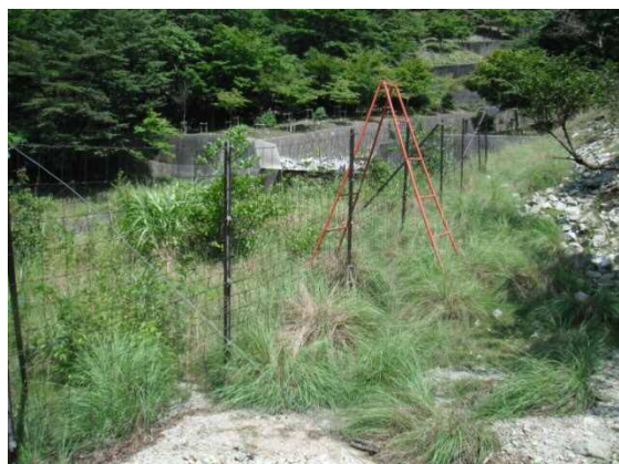
【施工前】（平成20年8月撮影）
