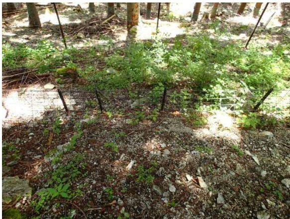
写真 28: 土壤保全工(金網柵工)の様子
