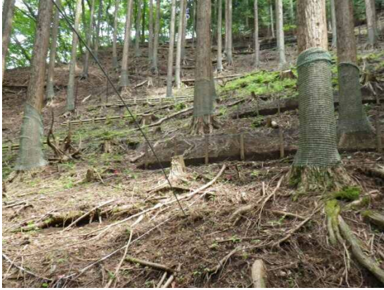
写真 14：土壌保全工設置箇所（白石沢） （左：丸太筋工・右：金網柵工）
