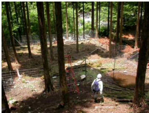
【施工直後】（平成 21 年 6 月撮影）
