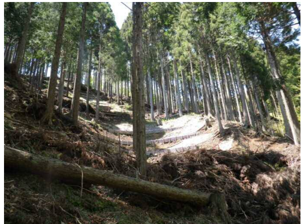
丸太筋工設置箇所(大滝沢)
