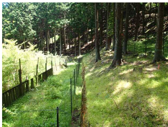
【施工後】（平成 28 年 7 月撮影）
