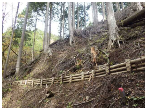
写真 25：植生保護柵外（大滝沢 N2）の状況（平成26年10月撮影）
