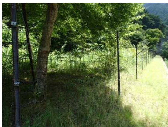
【施工後】（平成26年8月撮影）
