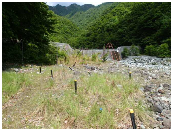
植生保護柵の設置状況(東沢)
