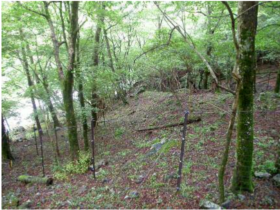
【施工直後】（平成 23 年 6 月撮影）
