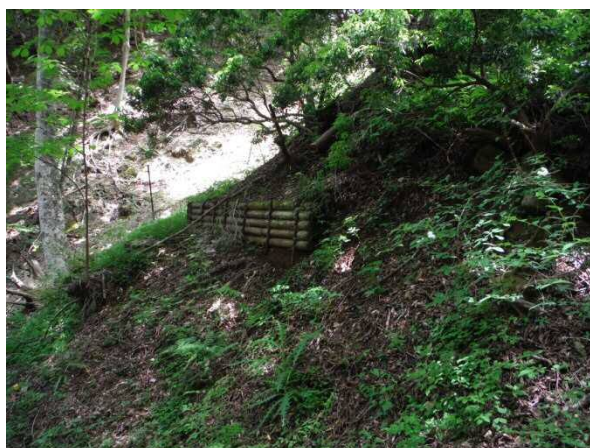
土壌保全工設置箇所（本谷川）
