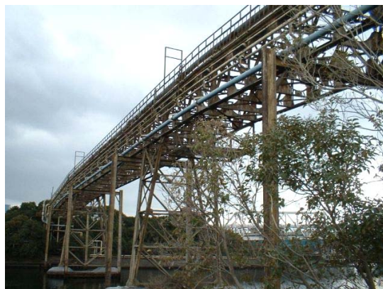
図1 ガス管橋全景
