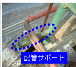
図2 配管漏えい箇所 (保温材を取り外し、 錆削り後の状況)
