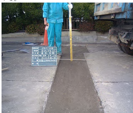
⑪ 路盤工 埋戻工同様、転圧の施工中、施工後の状況を各層毎に撮影し、スタッフ等で深さが分かるように撮影する。
