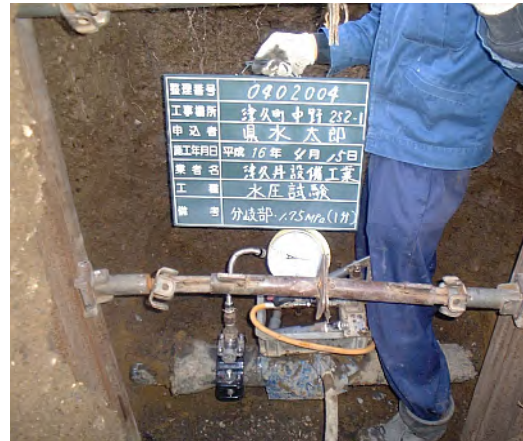
④ 水圧試験（分岐部）
