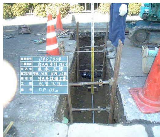
⑥ 配管状況
