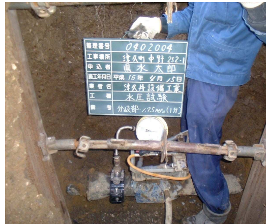
④ 水圧試験（分岐部）
