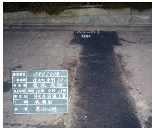
⑫ 仮設田 ①マーク及び掘削占用許可番号の表示、周囲の路面状況が分かるように撮影する
