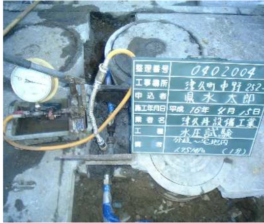
⑦ 水圧試験 (分岐～宅地内) 水圧が分かるように撮影する。
