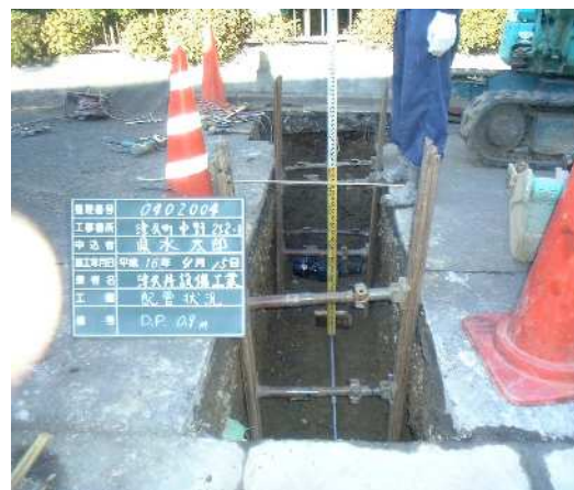
⑥ 配管状況
