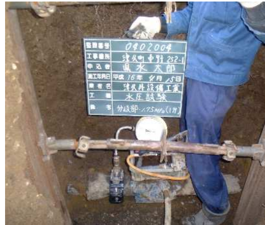
④ 水圧試験（分岐部）
