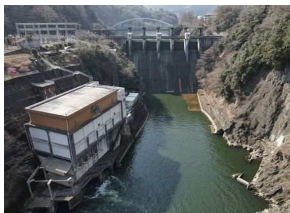
相模ダムと相模発電所
