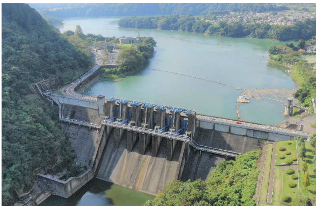
▲ 城山ダムと貯水池
