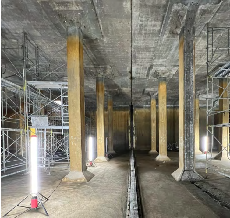
二本松配水池（藤沢市）内部の導流壁（構造体としての強度を有していない壁）を撤去した様子
