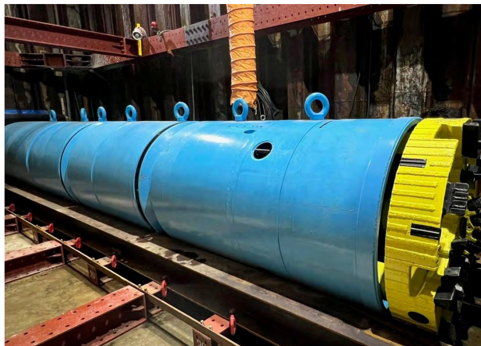
平塚市田村～浅間町地内基幹管路更新工事 シールドマシン設置の様子
