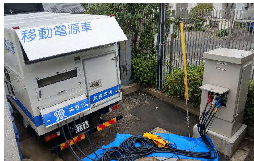
移動電源車に対応した設備
