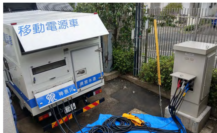
移動電源車に対応した設備
