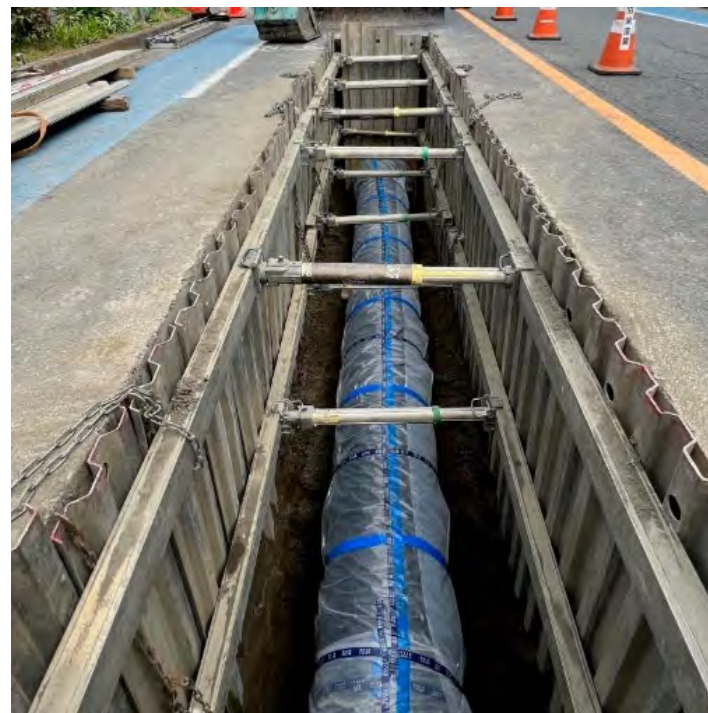
耐震継手管の布設した様子
