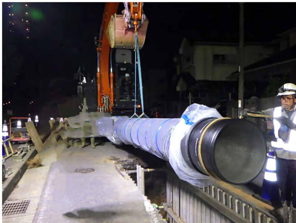
耐震継手管吊り下しの様子
