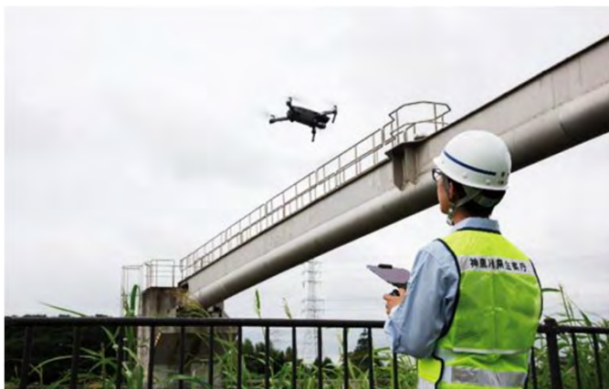
ドローンによる水管橋の点検
