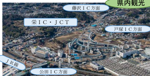
② 横浜湘南道路・高速横浜環状南線
