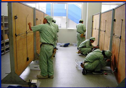
電気工事施工実習風景
