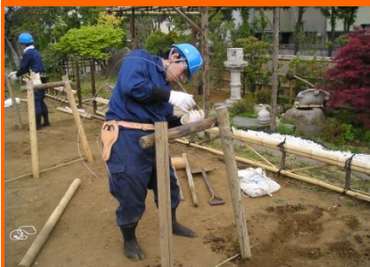
支柱実習 (写真4)
