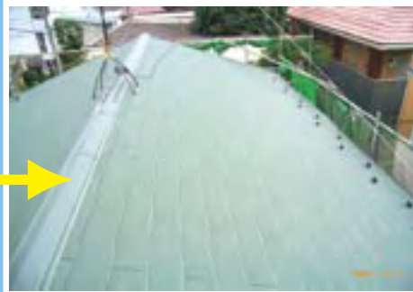
耐震改修(屋根の軽量化)
