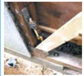
耐震改修(筋かい補強)
