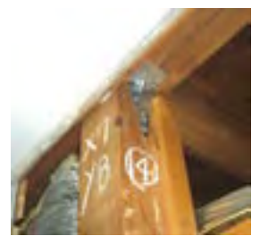
耐震改修(接合部の補強)
