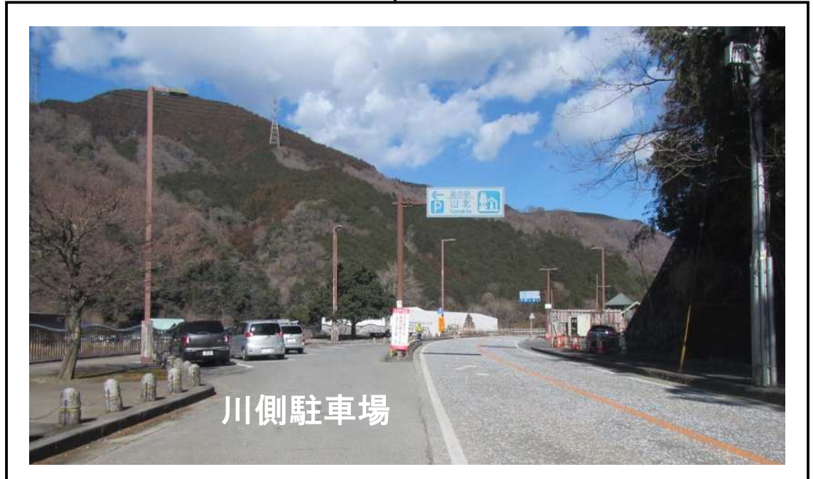
リニューアル工事中もご利用可能です。
