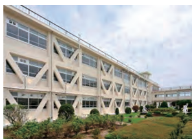
西湘高校 耐震補強工事
