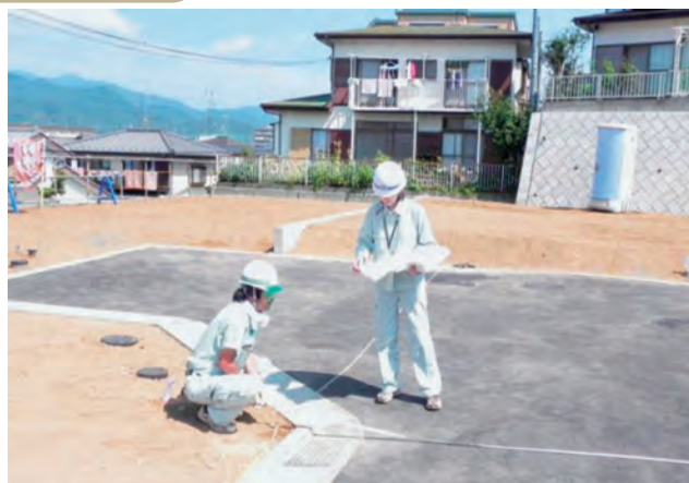
開発許可の現場完了検査
