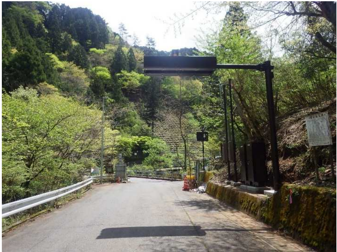
道路情報提供装置を清川村側よりのぞむ
