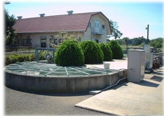
家畜用浄化槽
