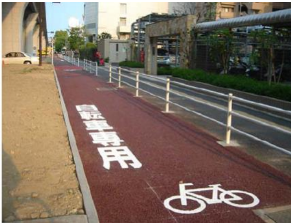
歩道拡幅・自転車専用レーン設置（金沢地区）
