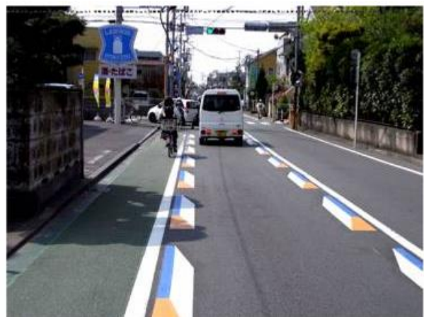
車道側に立体路面標示（茅ヶ崎地区）
