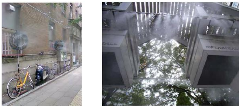
図2.2.4 ミスト冷却装置設置例
