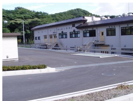
写真4 (退出時用トラックスケール)
