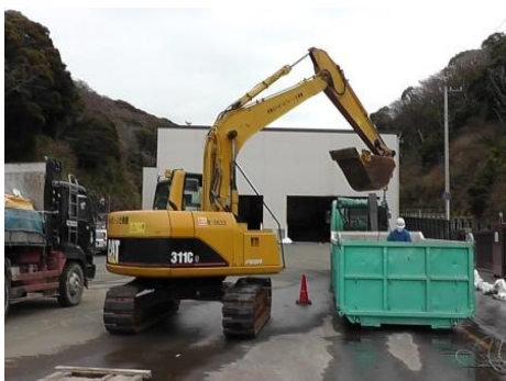
写真7 (吊り作業場所)
