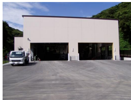
写真6 (建屋 搬入施設)
