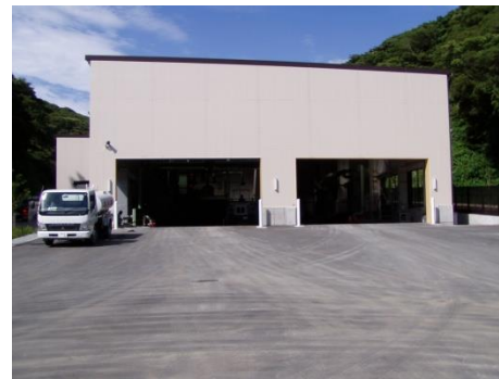
写真6 (建屋 搬入施設)
