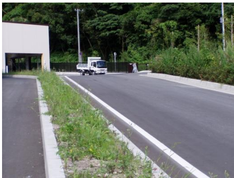
写真5 (搬入施設への道路)
