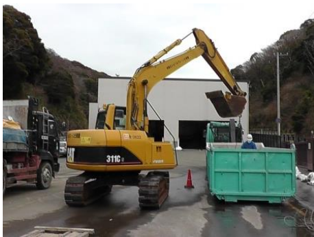
写真7 (吊り作業場所)
