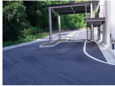
写真2 (搬入時用トラックスケール)
