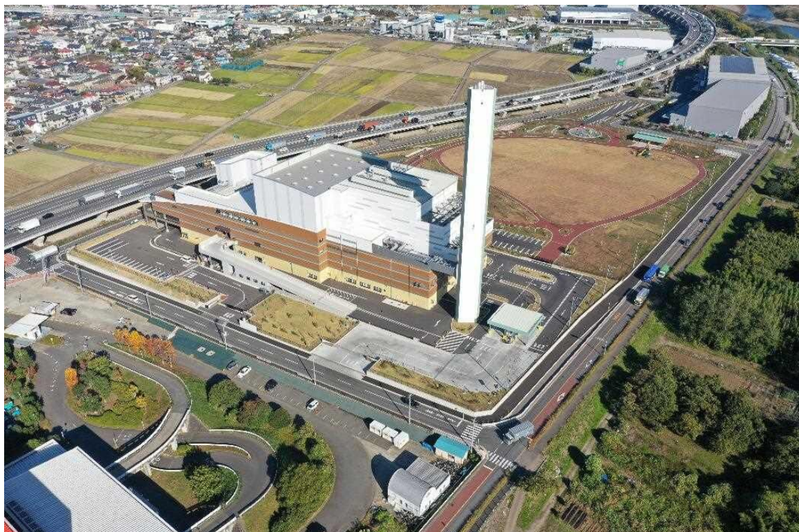
図 1-4-2 対象事業の工事完了後の写真
