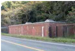
走水水源地の煉瓦造貯蔵池。明治35（1902）年の建設で道路反対側の駐車場には水栓が設置されている。走水水源池は全国的にも珍しい海を臨む低地である（写真提供：横須賀市上下水道局）
