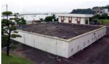
明治41（1908）年築の走水水源池の浄水池。鉄筋コンクリート製では、現存するもので国内最古級。見学はできないが遠望できる（写真提供：横須賀市上下水道局）
