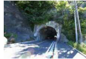
山並が海に迫る地形に鉄道や道路がつくられ、全国一トンネルの多い街となった横須賀市。複雑な地形は軍港の機密を守る上でも効果的だった。
