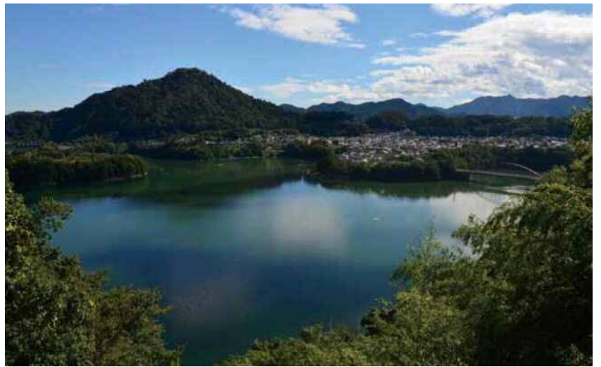
津久井湖は昭和40(1965)年のダム建設で、相模川が堰き止められてできた湖。水力発電や水がめとして相模川の恵みを県内にもたらしている。
