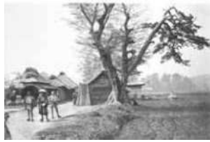
上海の商人リチャードソンが殺害された生麦事件の現場付近の幕末写真。横浜で暮らしていた英国人写真家のペイトが撮影した（横浜開港資料館蔵）
