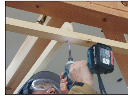
建築施工総合実習
