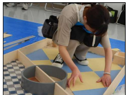
内装施工 (床仕上げ)
