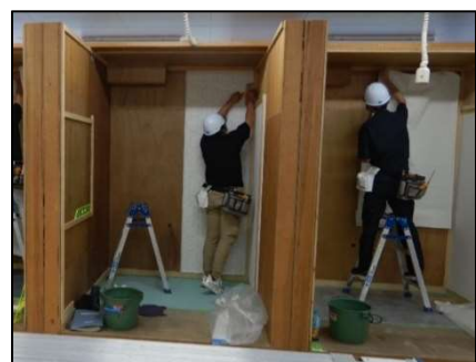
内装施工 (壁装)
