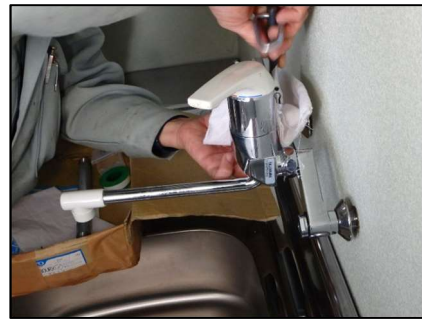
給排水設備工事 (器具取付け)
